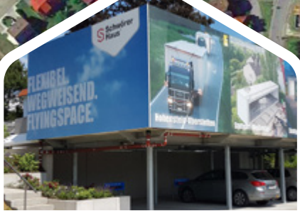
HS8 Empfangsgebäude für Werksführungen Hans-Schwörer-Straße 8 72531 Hohenstein
