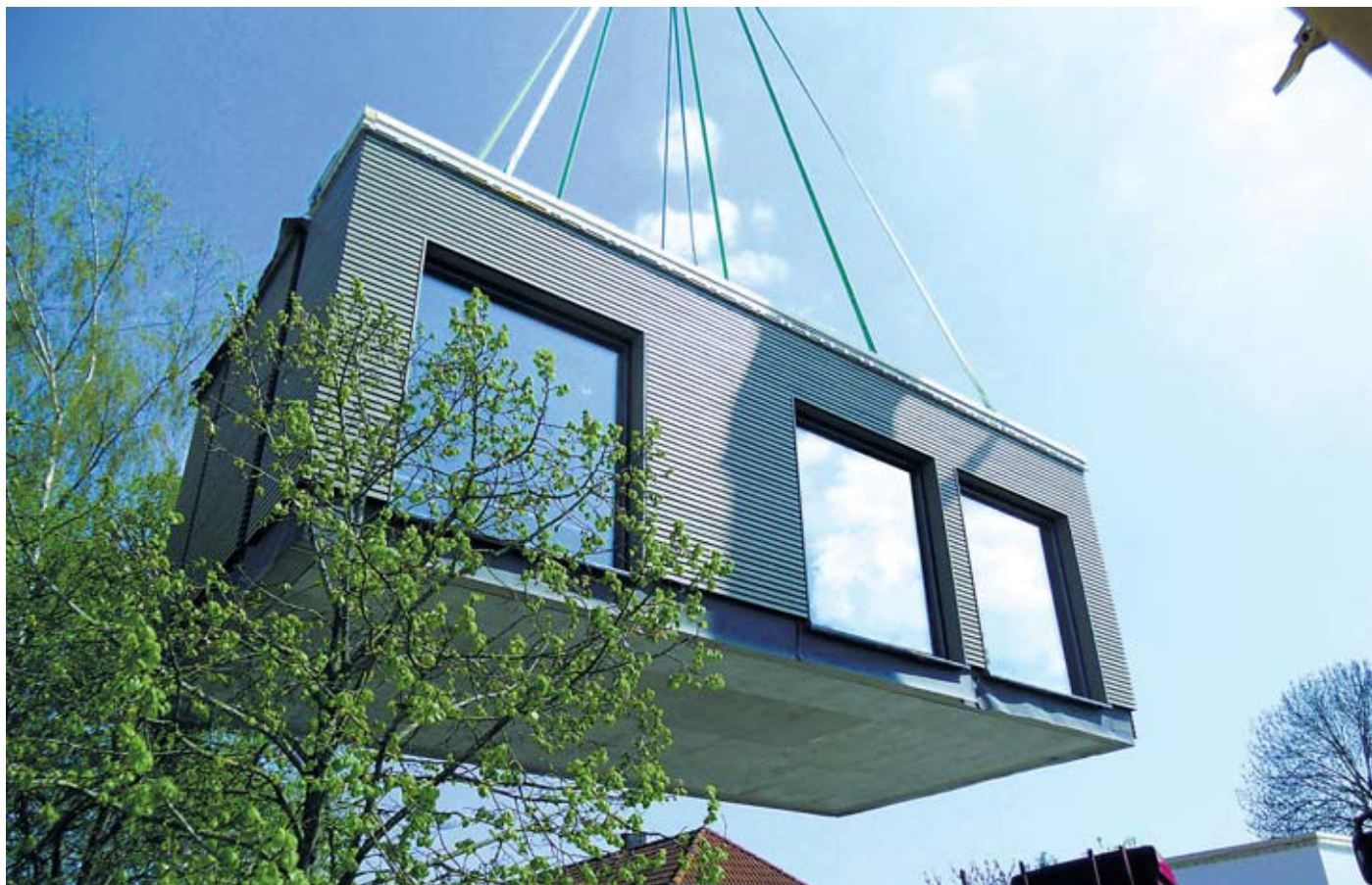
Flying Spaces nennt sich dieses Modul, das mithilfe eines Krans überall aufgestellt werden kann Foto: SchwörerHaus
