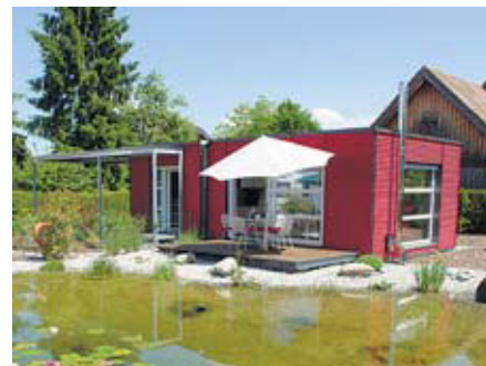
Eingehüllt in Alu-Wellprofil ist dieses Ferienhaus Foto: Krauss GmbH
