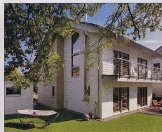
... für dieses Haus mit thermischer Solaranlage und kontrollierter Lüftung. SchwörerHaus
