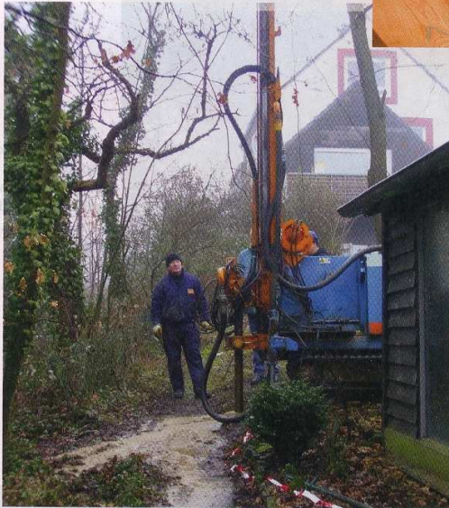
Eine Bodenuntersuchung ist immer empfehlenswert, in Bergbau-Gegenden gehören Probebohrungen dazu.
