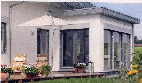
Wohnraum, Wintergarten, Terrasse – die Bereiche gehen hier fließend ineinander über, vor allem während der Sommerzeit.
